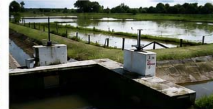
Bangunan sadap / pengatur debit
