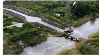
Bangunan bagi dengan pengukur dan pengatur debit
